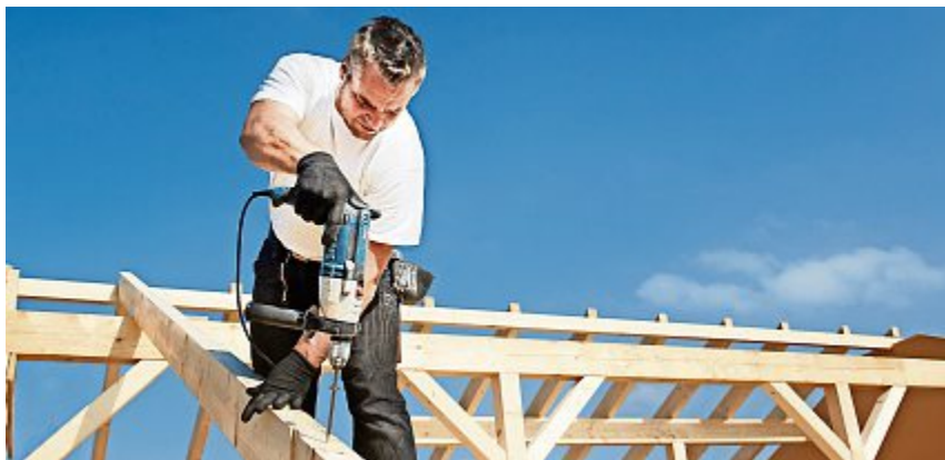
Zimmerleute montieren schwere Holzelemente in grosser Höhe.
