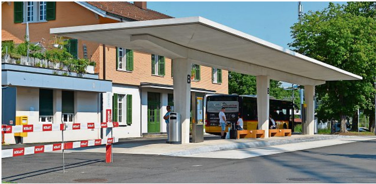
Die Gesamterneuerung des Bahnhofplatzes in Flawil ist in vollem Gange. So wurde unter anderem der Platz bereits saniert. ila
